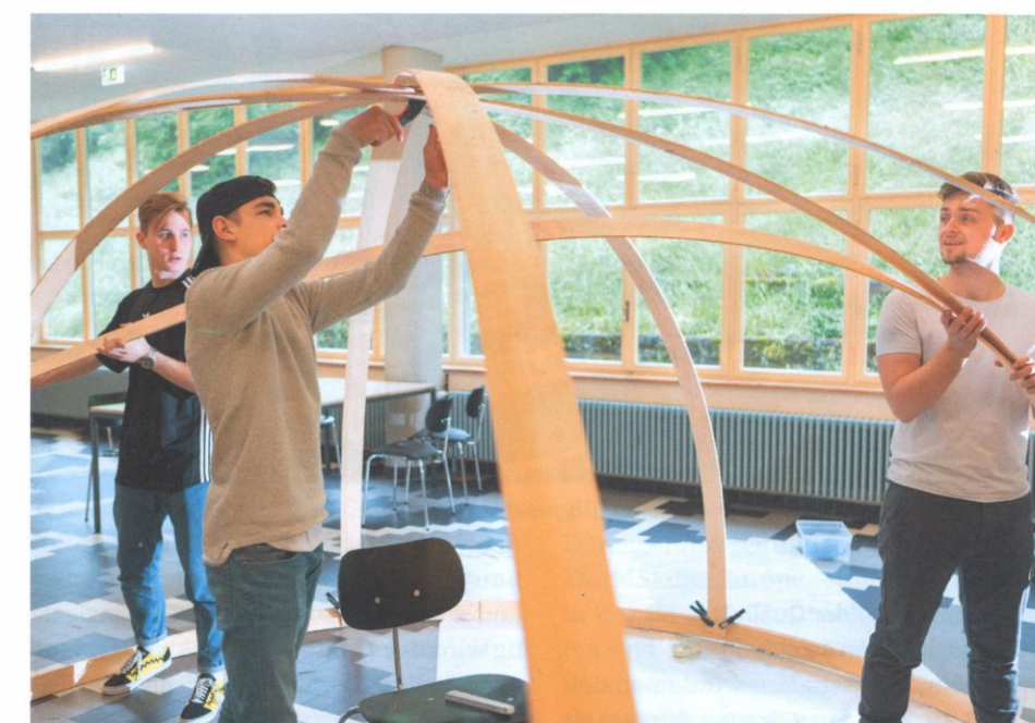
Eine Kuppel aus gespanntem Holz entsteht.
